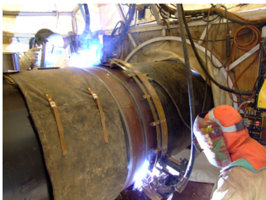
Bild 7: MAGF-Orbitalschweißung mit Rutilfülldraht im Pipelinebau
