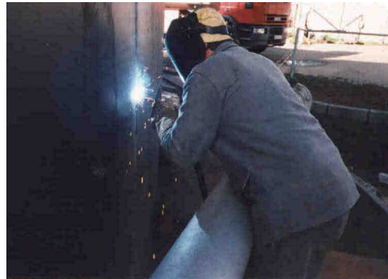
Bild 6: Anwendungsbeispiel Tankbau: Schweißung auf keram. Badsicherung Pos. PF mit Rutilfülldraht (schnell erstarrend)
