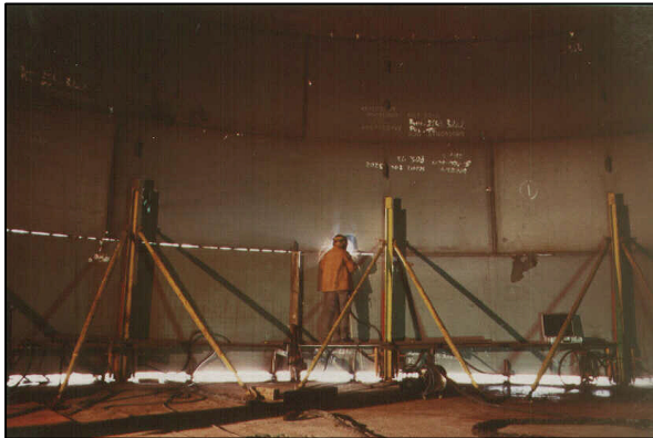
Bild 9: Anwendung von basischem Fülldraht im Tankbau Baustelleneinsatz in Pos. PC
