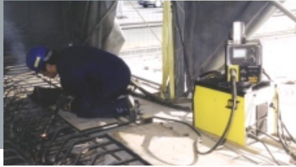
ESAB-Prozesspaket 114 im Baustelleneinsatz
